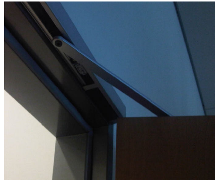
E-Magnet in der Gleitschiene
