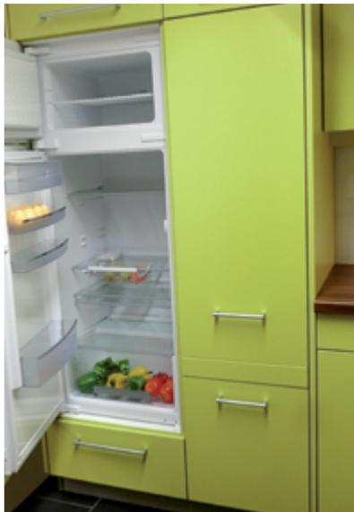
*Erhöht eingebaute Kühl-Gefrier-Kombination, Unterkante ca. 40 cm*
